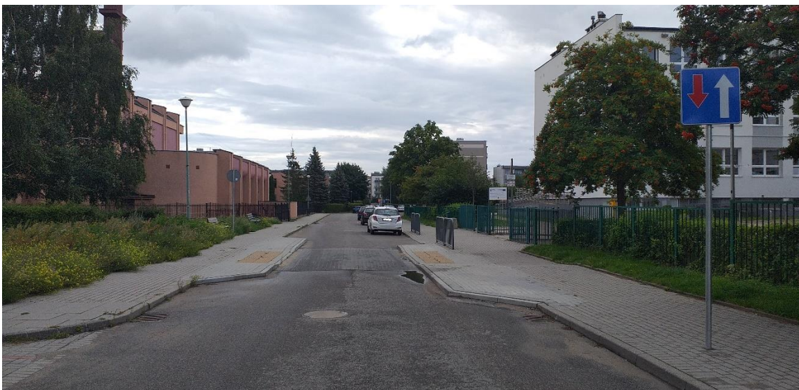
widok z drugiej strony na spowalniacz i szykanę w miejscu starego przejścia dla pieszych
