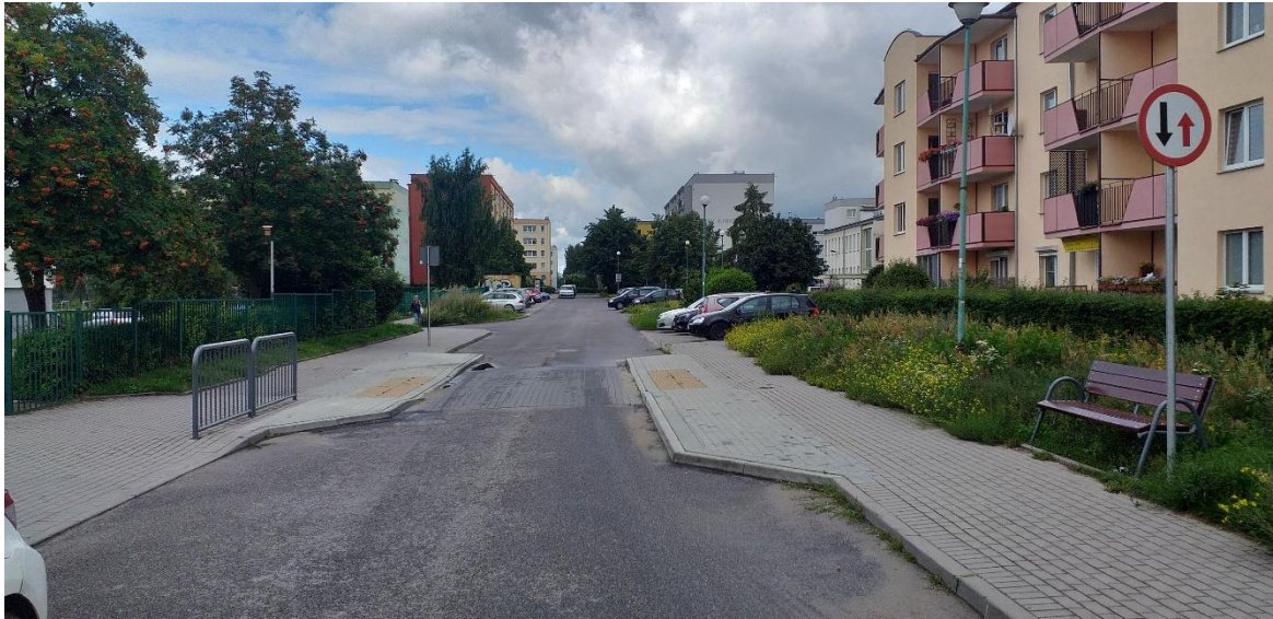
spowalniacz i szykana w miejscu starego przejścia dla pieszych
